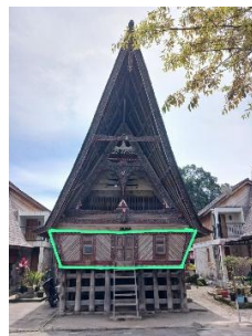
Gambar 2. Bagian tengah Rumah Bolon
